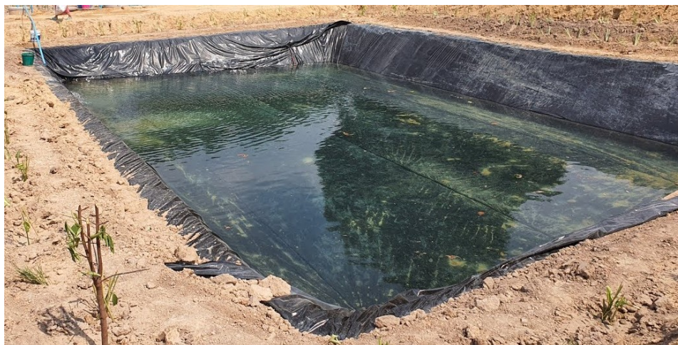
รูปที่ ๒๑ แสดงตัวอย่างบ่อน้ำจืดปูพื้นบ่อด้วยแผ่นพลาสติก
